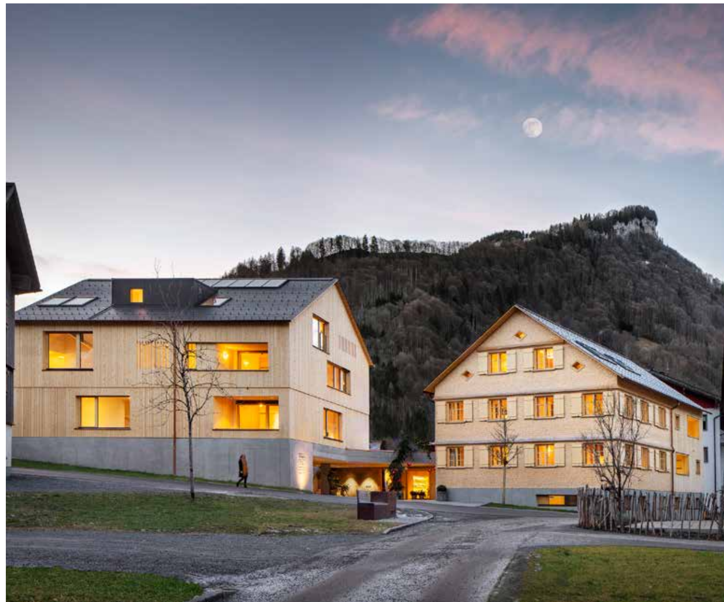
Tempel 74, die neuen Apartmenthäuser in Mellau
